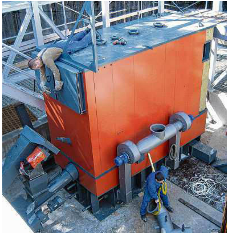
Der Kessel wird montiert, die Anschlüsse werden hergestellt. Im gesamten Gebäude wurden fünf Kilometer Rohrleitungen verlegt.
