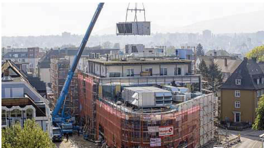
Ein riesiges Projekt und Herausforderung für Tröndle Haustechnik: Das neue Hochrhein-Center in Rheinfelden mit einer Nutzfläche von 7500 Quadratmetern. BILDER: THT
