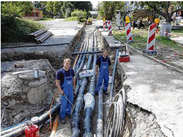
2,6 Kilometer Fernleitungen wurden verlegt, um private und öffentliche Gebäude anschließen zu können.
