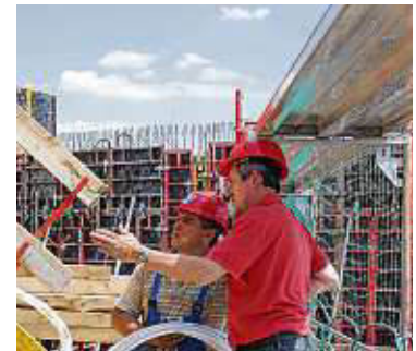
Stephan Tröndle, rechts, macht sich ein Bild vom Fortschritt der Arbeiten.
