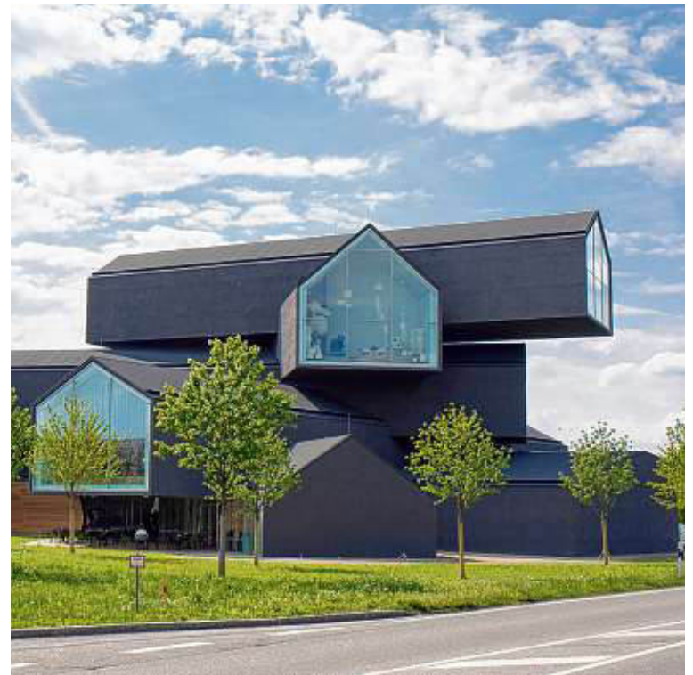
Das VitraHaus in Weil am Rhein steht für modernste Architektur. Hier installierte Tröndle Haustechnik die anspruchsvolle Haustechnik. BILD: TRÖNDLE HAUSTECHNIK
